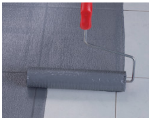
Aplicación a rodillo de Eco Prim Grip Plus sobre pavimento existente de losetas de gres porcelánico
