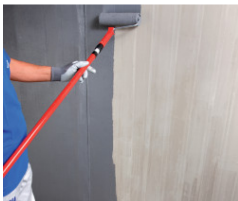
Aplicación de Eco Prim Grip Plus a rodillo sobre soporte de hormigón
